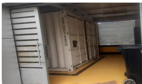
Figura 36 Identificación de disposición final en el Hospital Isidro Ayora
