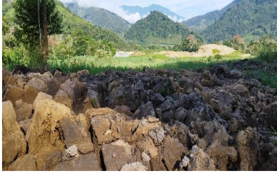
A: Erosión del suelo en la zona
