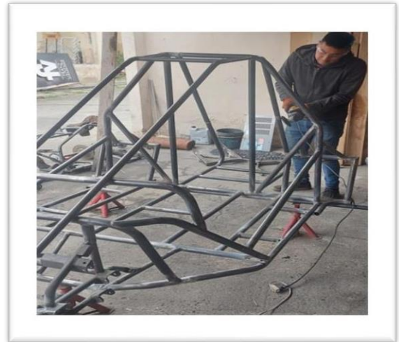
Fig. 55 Proceso de pulir con una máquina amoladora
