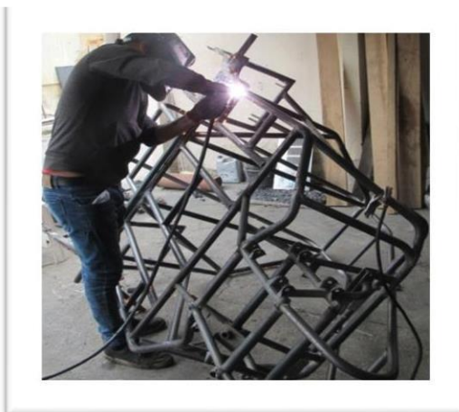
Fig. 54 Soldadura de toda la estructura
