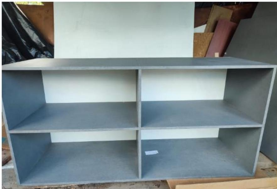
*Nota:* Posteriormente como indica la figura 16 ya cortadas todas las partes se procedió con el montaje de la base inferior y superior de dicho proyecto, el mismo se procedió a montar las piezas con uniones con pernos.
