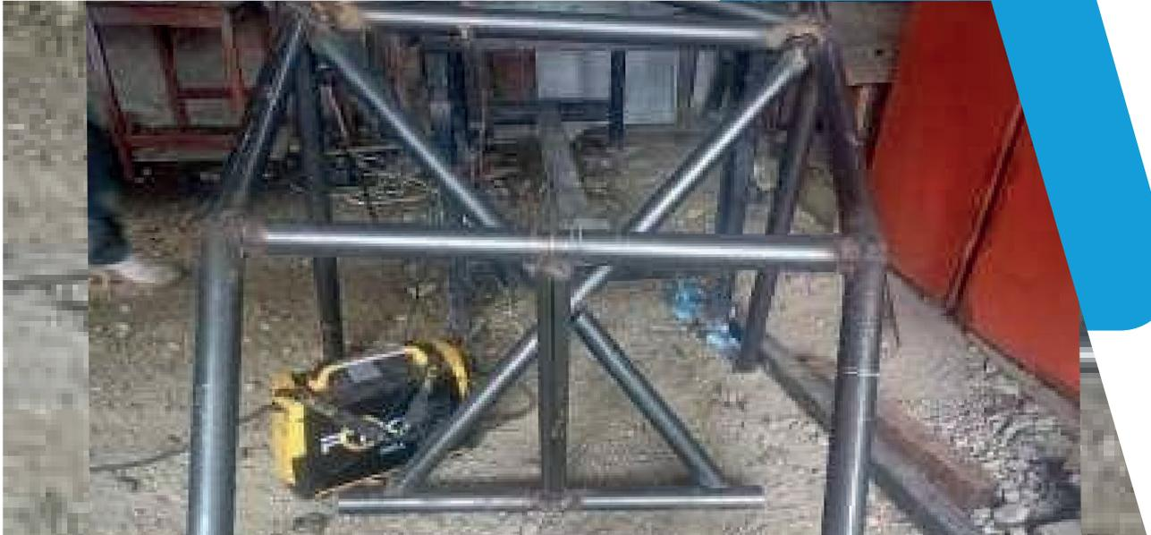
La figura 26 nos indica la vista posterior del tirante diagonal ya una vez puesto en la estructura,
