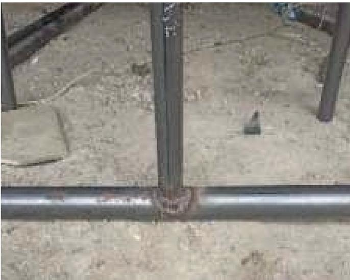
Se examina el tirante o refuerzo opcional que está en horizontal con una medida de 85cm utilizando un tubo de 2 pulgadas con un espesor de 1.5mm
