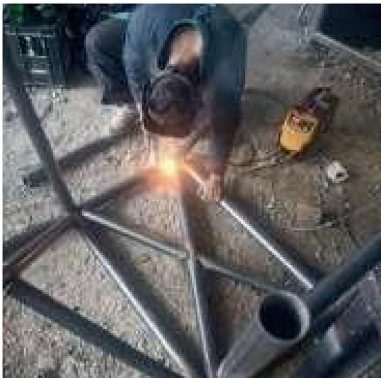
Se puede ver la unión del último tirante para poder obtener el refuerzo techo en tipo X.
