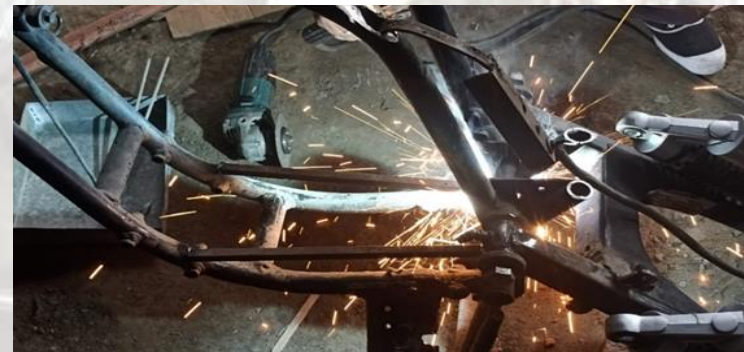
FIGURA N° 23: soldadura de varillas para colocar la base de la batería FUENTE: proyecto
