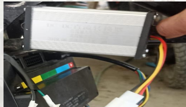
FIGURA N° 32: convertidor dc dc instalado. FUENTE: proyecto
