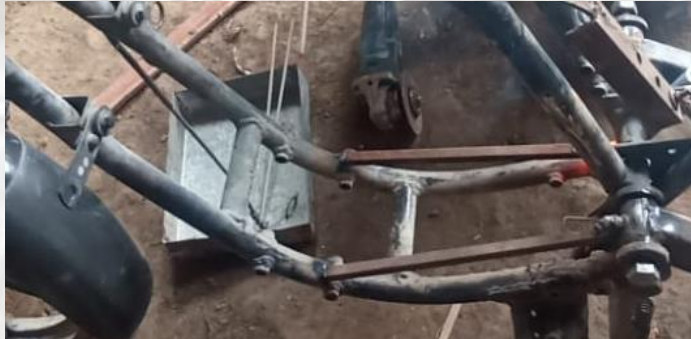
FIGURA N° 24: varillas soldadas FUENTE: proyecto
