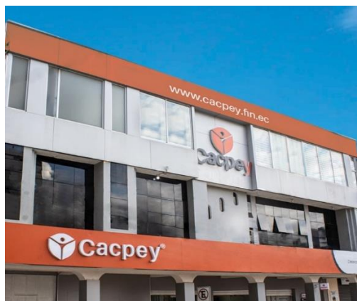
Edificio CACPE - Yantzaza
