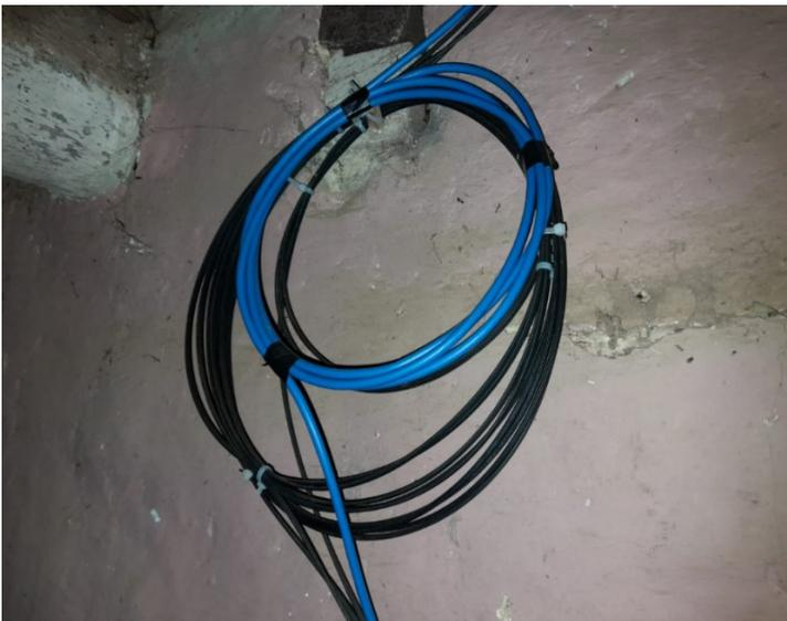
*Nota.* Fotografía tomada realizando el tendido de la fibra óptica y cable utp donde se muestra una reserva de cable para futuros mantenimientos o reparaciones.
