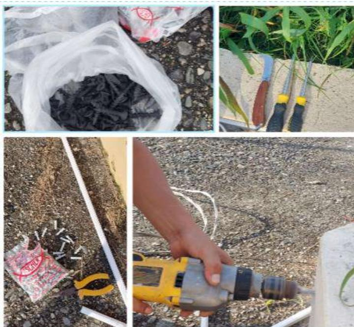
*Nota.* Perforación de orificios con el fin de sujetar la canaleta y ejercer una mayor estabilidad y durabilidad (imagen de autoría propia).
