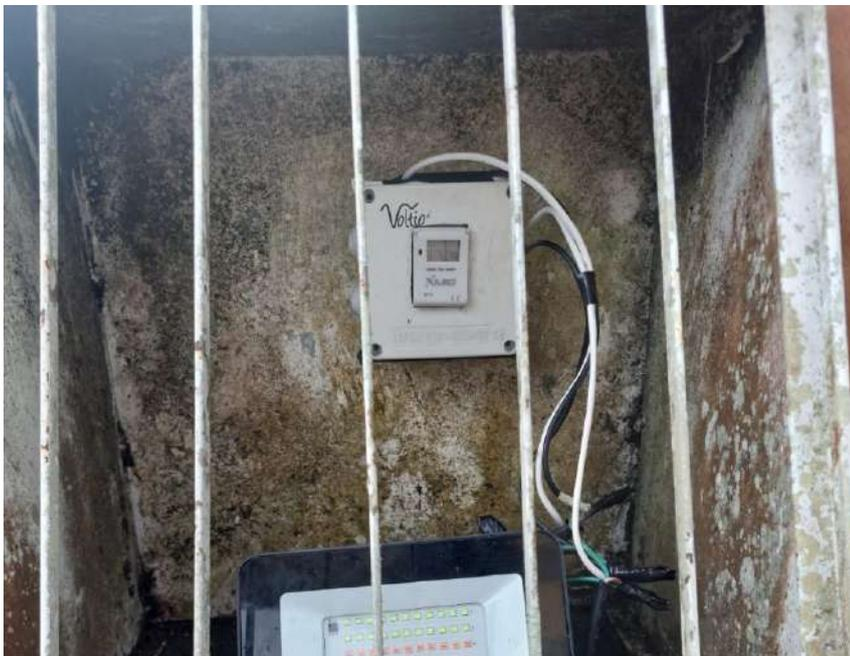
Nota. El dispositivo temporizador se ubica dentro de una caja modelo IP65, con el fin de resguardar tanto el dispositivo como las conexiones de los factores externos.
