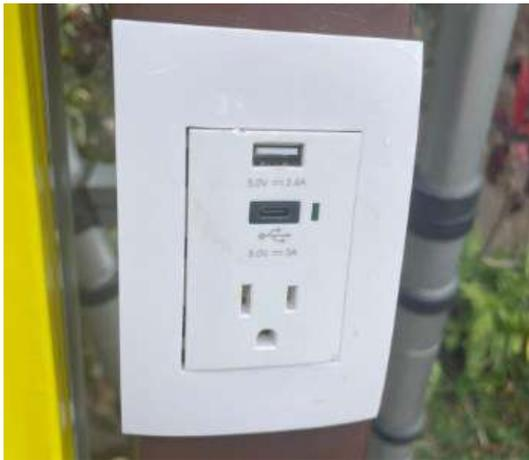
*Nota.* tomacorriente con tres entradas USB, tipo C, tomacorriente normal
