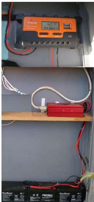
*Nota.* conexión de baterías controlador e inversor
