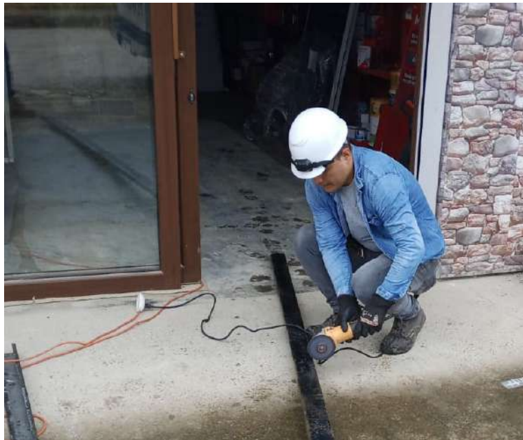
Armado de bases para paneles fotovoltaicos
