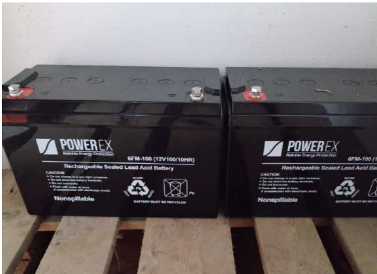
Montaje de 2 baterías solares
